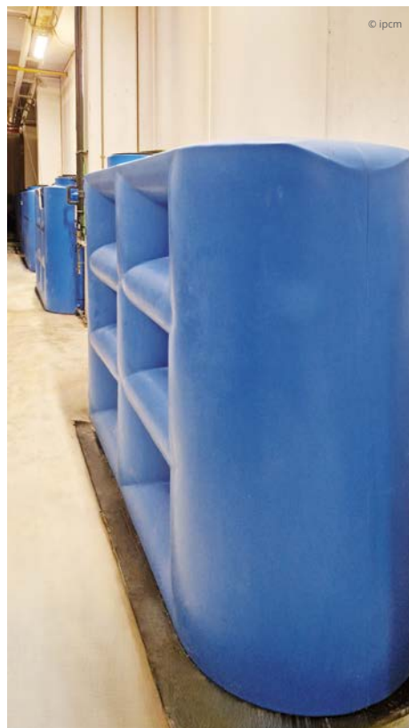
Il serbatoio di stoccaggio del distillato e il sistema di distribuzione delle tubazioni.
