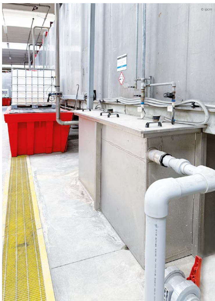
Le vasche del tunnel di pretrattamento e il PLC dell'impianto dell'evaporatore.
